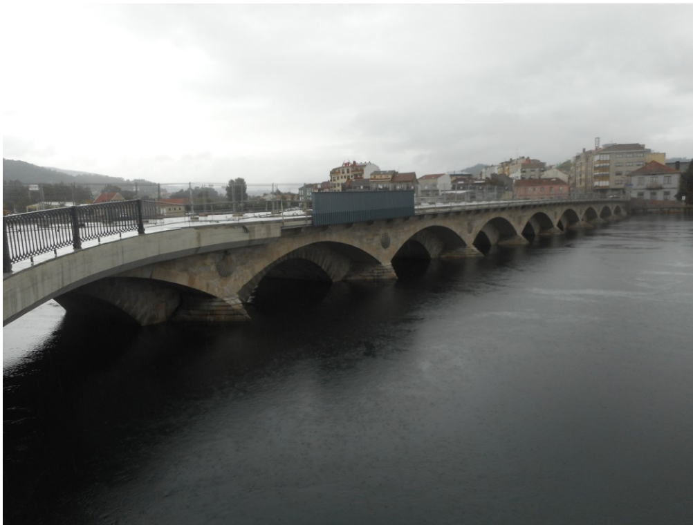
PONTEVEDRÁ PONTE O BURGO SUL FIUME LÉREZ
