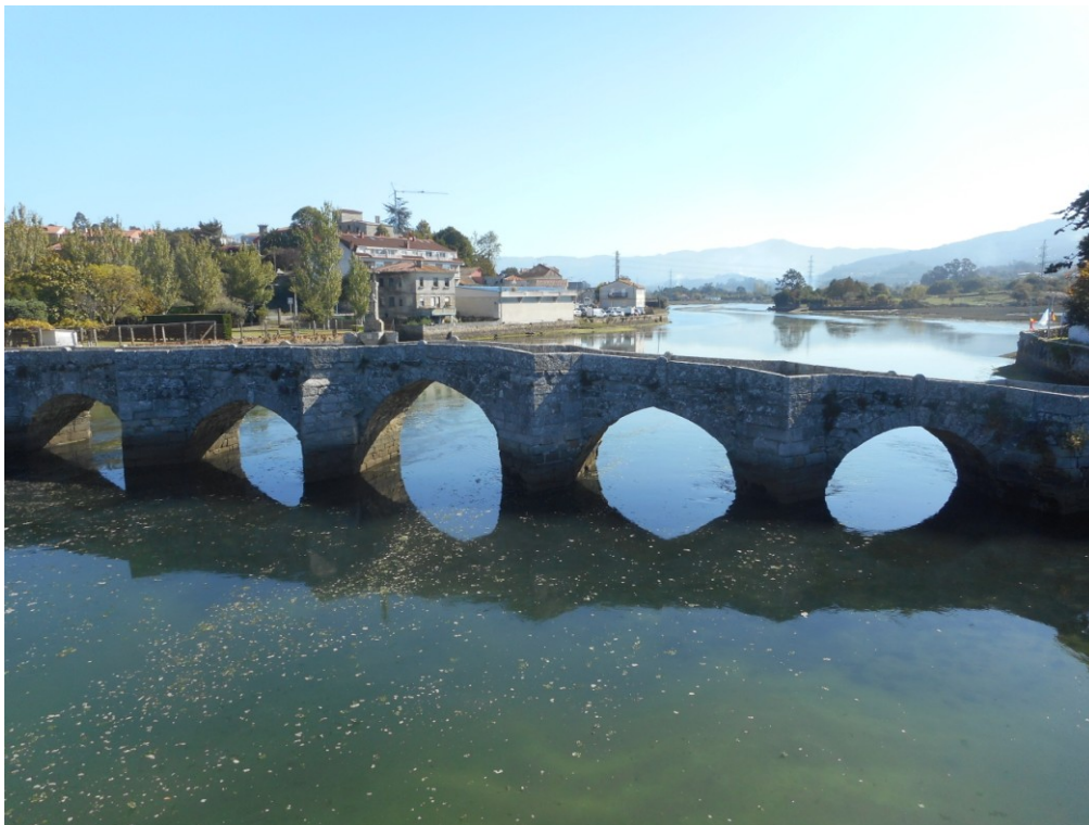
PONTE SUL RIO MIÑOR
